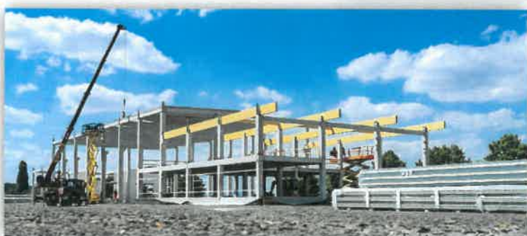
Výstavba nového obchodně-servisního střediska v Lounech
