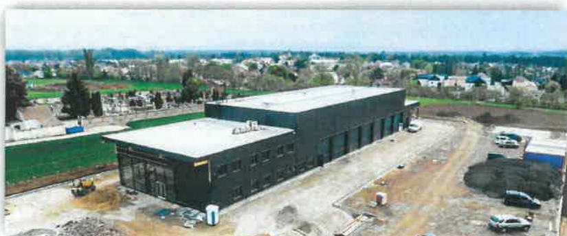
Výstavba nového obchodně-servisního střediska ve Smiřicích
